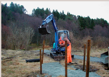
Montering av hinder nr. 15
