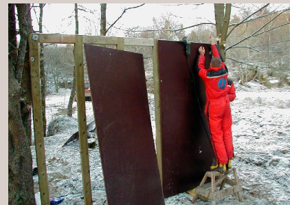
Montering av hinder nr. 4.
